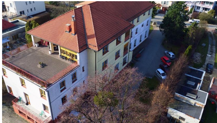
Pohled na budovu před revitalizací - původní nezastřešená terasa
