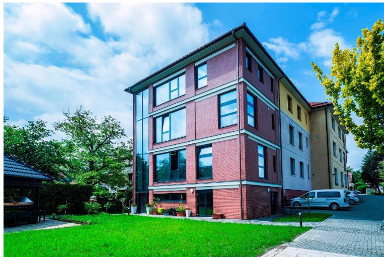
Pohled na přistavovanou část a zastřešení původní terasy
