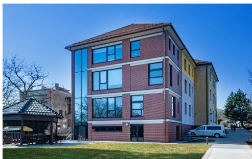
Pohled na budovu ze zahrady
